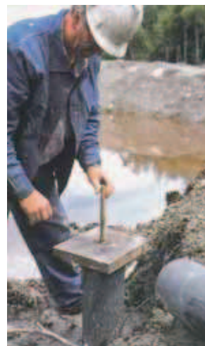
Bild 6: Setzen der Druckverteilerplatte
