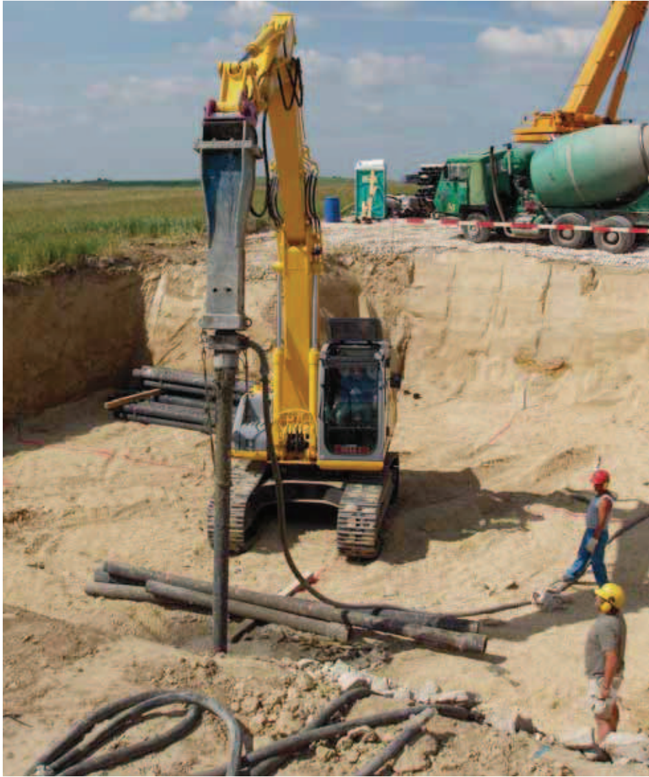
Bild 4: Rammen eines verpressten duktilen Pfahles in der Praxis am Beispiel einer Gründung für eine Windkraftanlage
