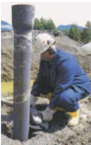
Bild 2: Abschneiden des überstehenden Pfahlstückes
